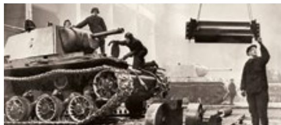
Производство тяжелых танков KB-1 на Ленинградском металлическом заводе. 1942 год
