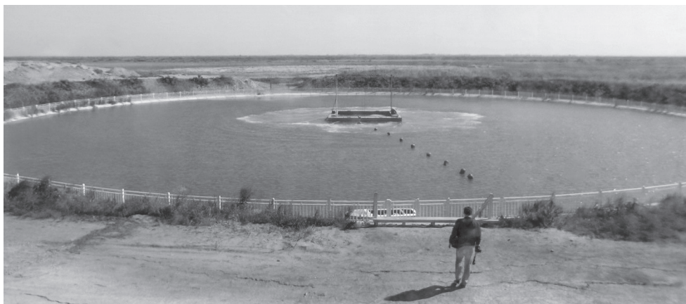
Рис. 3. Бассейн с аэрогидропушкой на понтоне
